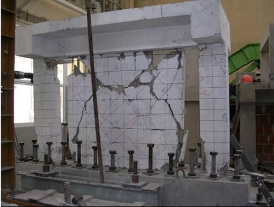
Şekil 7. Deney sonu hasar durumu
